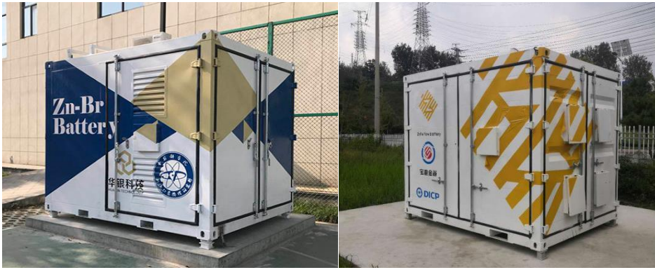
图 10 kWh 锌溴单液流电池示范系统及国内首套 10 kW 级碱性锌铁液流电池储能示范系统
